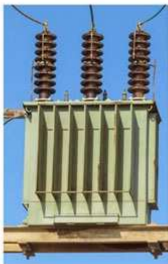
Transformador de Distribuição
